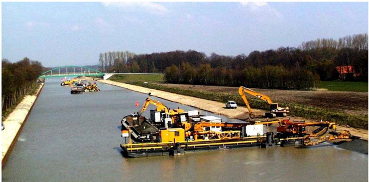
Abb.: Streckenbaumaßnahme am DEK
