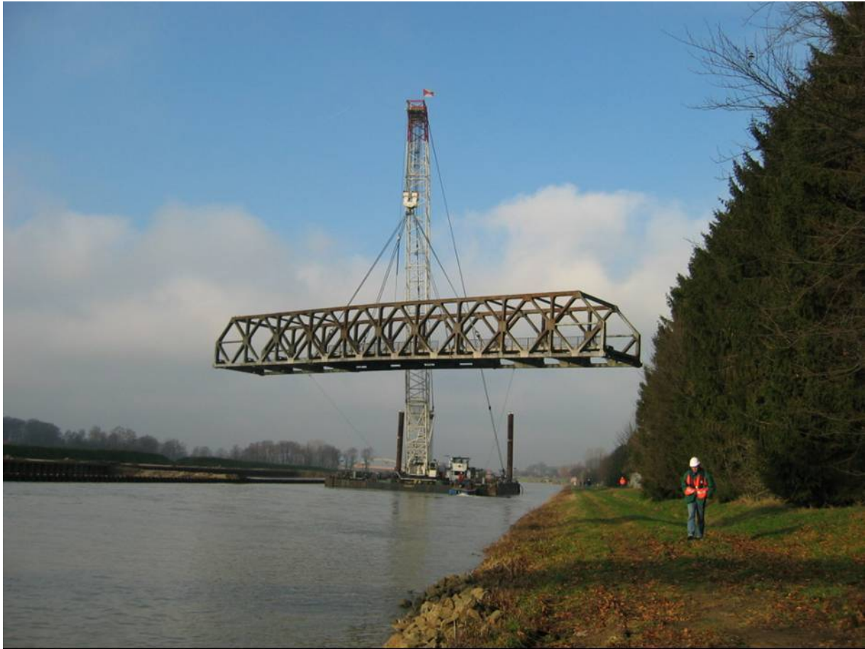
Abb.: Abbruch der Birgter Brücke DEK-km 102
