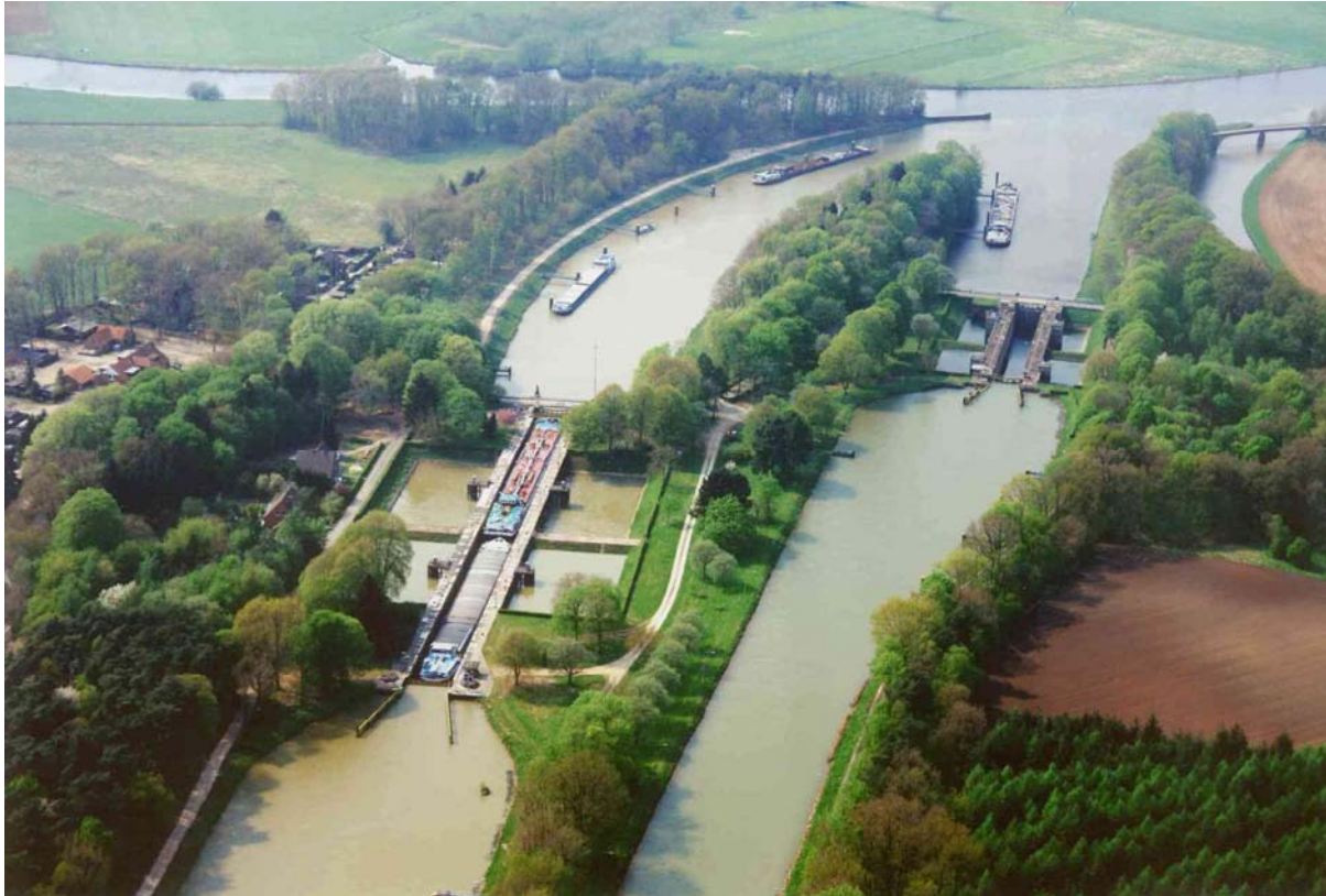
Abb.: Kanalstufe Gleesen bei DEK-km 137,9 (Hintergrund: Ems; links: große Schleuse Bj. 1914; rechts: kleine Schleuse Baujahr 1898)
