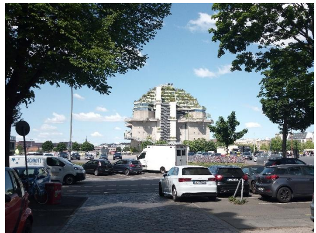
der umgestaltete Bunker am Heiliggeistfeld
