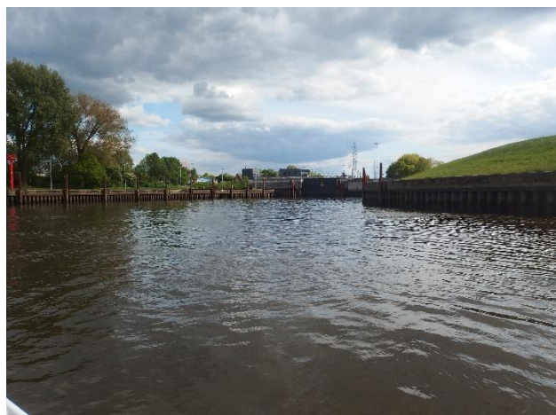
Schleusenzufahrt in Harburg
