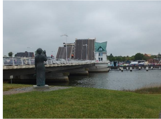
mit geöffneter Klappbrücke
