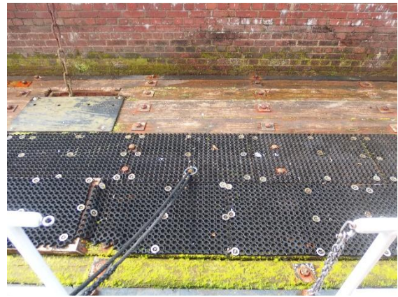
Der Steg mit Ringen in der Schleuse
