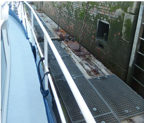
In Schleuse Brunsbüttel
